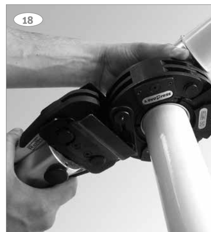
18: Placer grundbakken i preskæden og start maskinen. Fjern maskinen og presbakken når der er færdigpresset.
