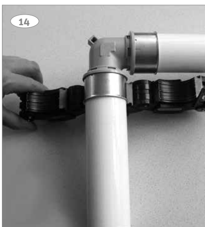
14: Placer preskæden på PressCheck® presringen.
